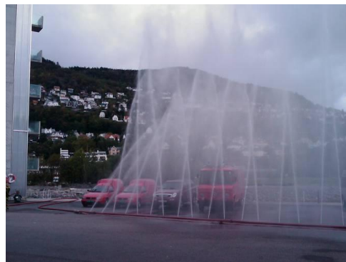
Figur 8 Brannslange med vannveggfunksjon
