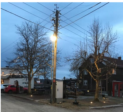
Bilde 16 over t.v. viser den historiske lysstolpen og spottene som lyser opp de 2 store trærne, en på hver side av hvert tre. Bilde 17 over i midten viser det nye dominerende el-skapet og kveiler til overs som nå oppfattes som skrot. Bilde 18 over t.h. viser ledninger og koplingskontakter som ligger løse og en spott som ligger utsatt til.
