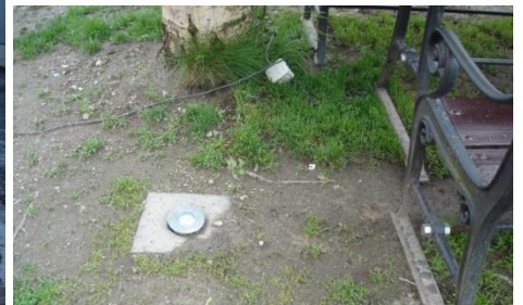
Bilde 16 over t.v. viser den historiske lysstolpen og spottene som lyser opp de 2 store trærne, en på hver side av hvert tre. Bilde 17 over i midten viser det nye dominerende el-skapet og kveiler til overs som nå oppfattes som skrot. Bilde 18 over t.h. viser ledninger og koplingskontakter som ligger løse og en spott som ligger utsatt til.
