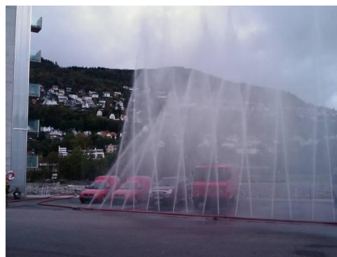
Figur 8 Brannslange med vannveggfunksjon
