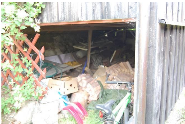
Figur 5 Lagring under bygg og inntil fasade bør unngås.
