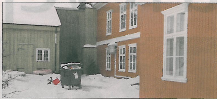
BRANNTILLØP: Ifølge brannvesenet kunne det gått riktig ille, om branntilløpet i denne bakgården i Alfs gate hadde skjedd på natten eller tidlig om morgenen.
